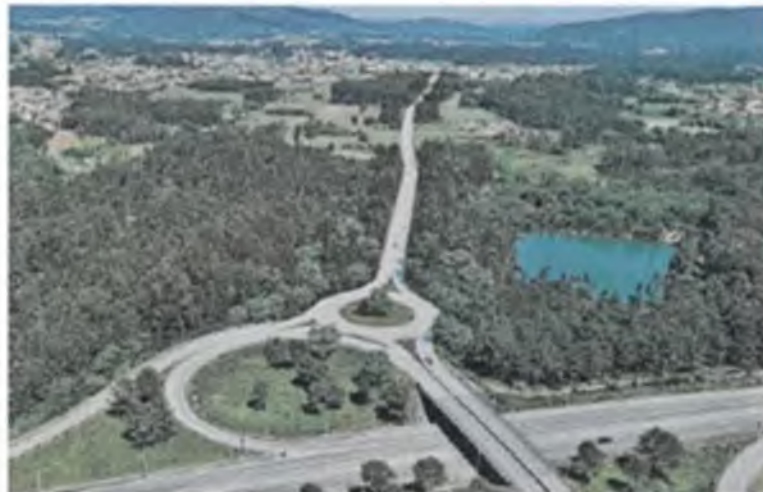
Novo Acesso Rodoviário da Zona Industrial do Vale do Neiva ao Nó da A28
