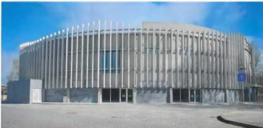
Reabilitação e refuncionalização da Praça Viana
