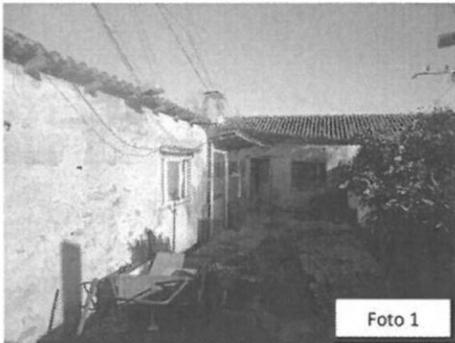
*“2. Prédio de habitação de rés-do-chão, sito na rua das Dálías, n.º 457, a ser habitado pelo agregado familiar do Sr. Ismael Navarro, executado em alvenaria de tijolo cerâmico e cobertura em telha cerâmica, com as medidas de 6,62m X 5,91m (39,12m<sup>2</sup>) (foto 2);”*
