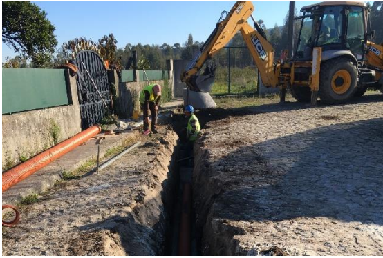
Ampliação das redes de abastecimento de água e saneamento
