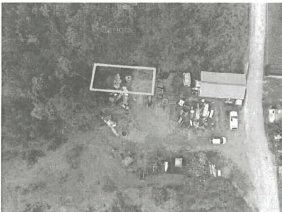
Imagem do local de instalação
