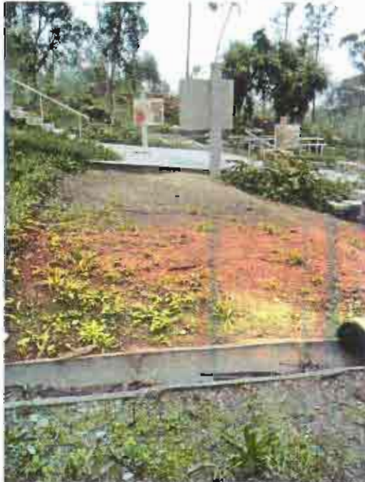
INTERRUPÇÃO DO CAMINHO EXISTENTE DO LADO SUL
