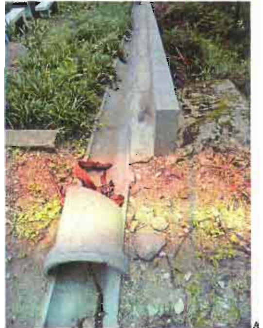
INTERRUPÇÃO DO CAMINHO EXISTENTE DO LADO SUL
