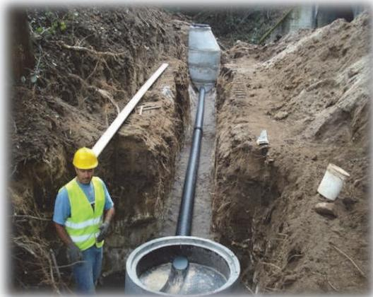
Ampliação das redes de água, águas residuais e pluviais - Ligação de águas residuais – Darque
