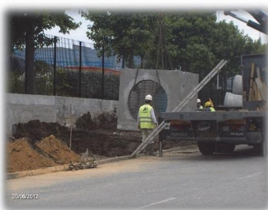
Rede drenagem de águas pluviais - Correção de ligação existente na Zona Industrial do Neiva
