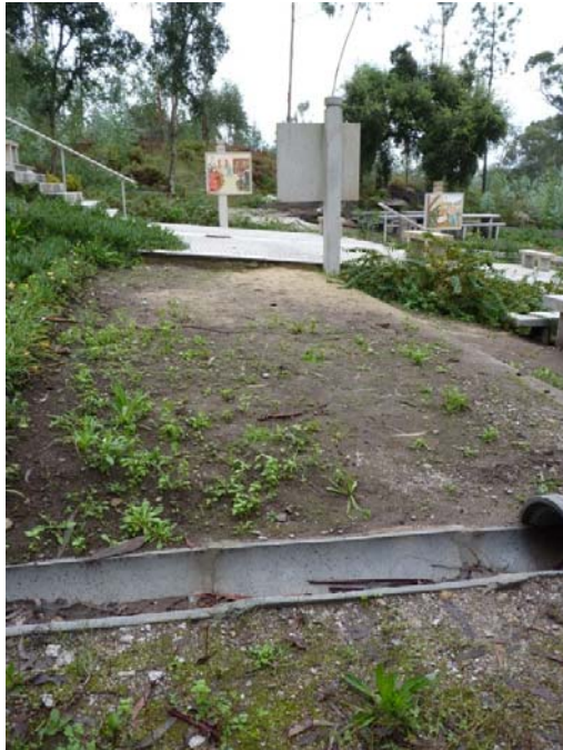
INTERRUPÇÃO DO CAMINHO EXISTENTE DO LADO SUL
