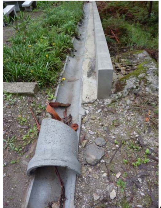
INTERRUPÇÃO DO CAMINHO EXISTENTE DO LADO SUL
