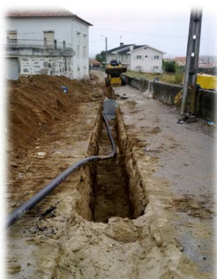
Instalação da conduta de elevatória de saneamento
