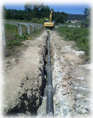
Instalação de coletor
