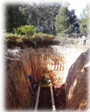
Perfuração horizontal no caminho de ferro
