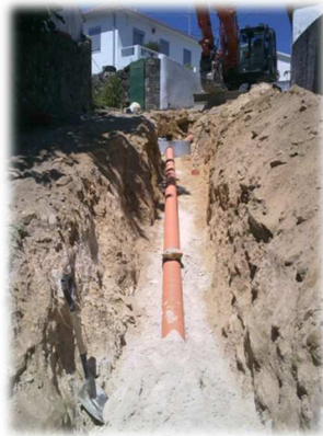
Instalação de rede de saneamento
