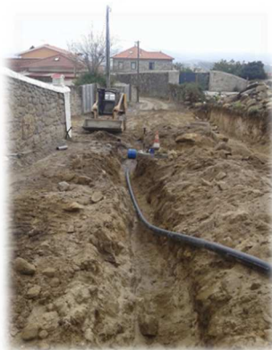
Instalação conduta de água
