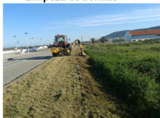
Limpeza de bermas
