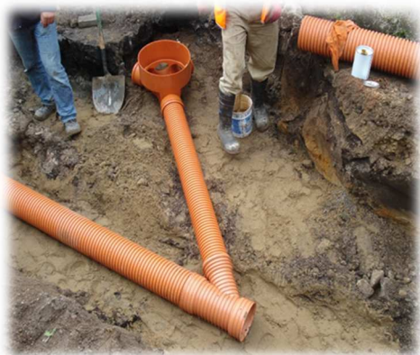
Instalação de ramal de águas residuais
