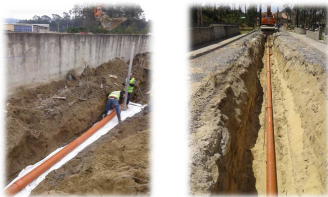
Instalação do coletor de águas residuais
