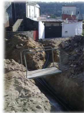
Instalação da conduta de elevatória residuais
