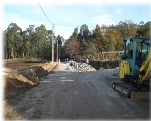
Trabalhos de pavimentação em cubo
