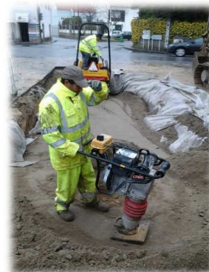
Compactação da vala, reparação do coletor
