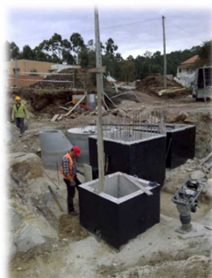
Acabamentos na Estação Elevatória
