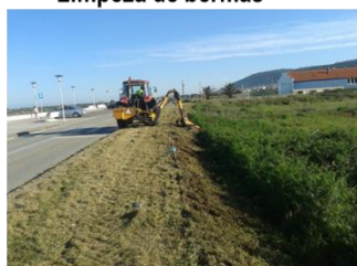
Limpeza de bermas
