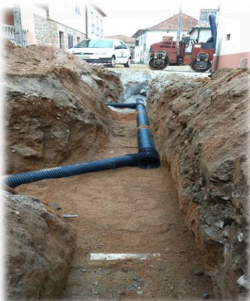
Figura n.º 7 – Instalação de coletor de saneamento
