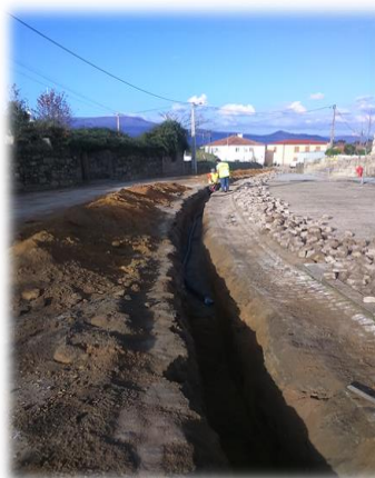
Figura n.º 8 – Instalação de conduta de água
