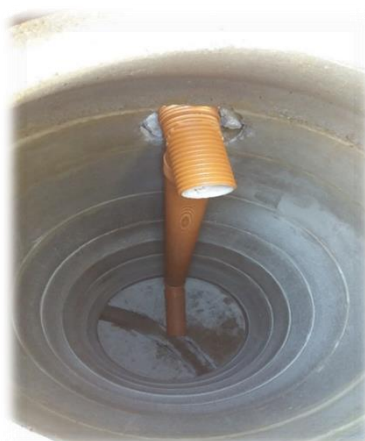
Figura n.º 17 e n.º 18 – Instalação de coletor residual e queda guiada em caixa de visita
