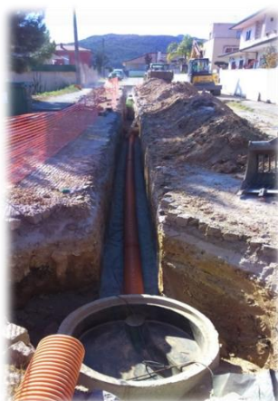
Figura n.º 15 e n.º 16 – Instalação de ramal de águas residuais e caixa de visita
