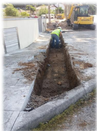
Figura n.º 15 e n.º 16 – Instalação de ramal de águas residuais e caixa de visita
