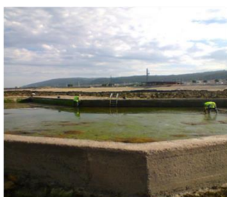
Lavagem piscinas água natural
