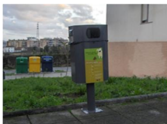
Colocação de equipamentos
