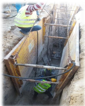
Figura n.º 17 e n.º 18 – Instalação de coletor residual e queda guiada em caixa de visita
