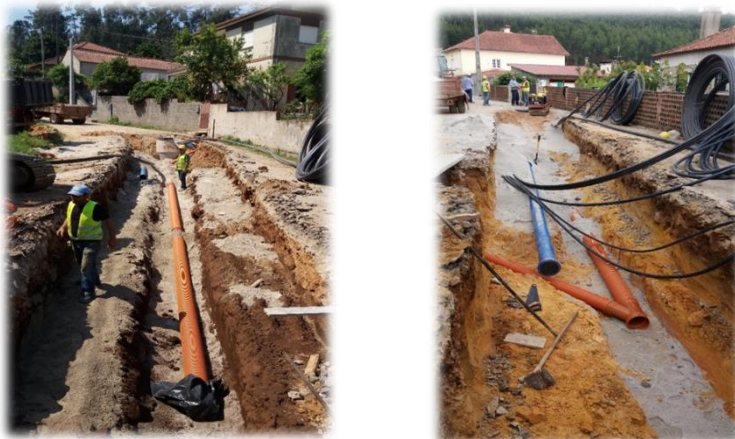
Figura n.º 11 e n.º 12 – Instalação de coletor de águas residuais coletores
