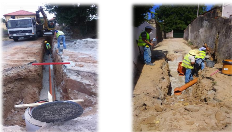
Figura n.º 13 e n.º 14 – Instalação de coletor de águas residuais e ramal
