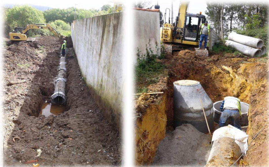
Figura n.º 1 e n.º 2 – Instalação de rede residual e pluvial, e execução de caixas de visita
