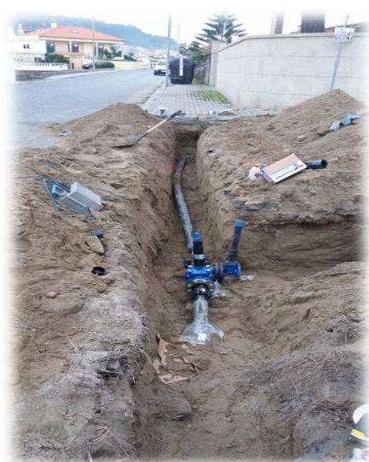
Figura n.º 8 e n.º 9 – Instalação de rede de água e execução de nó de ligação
