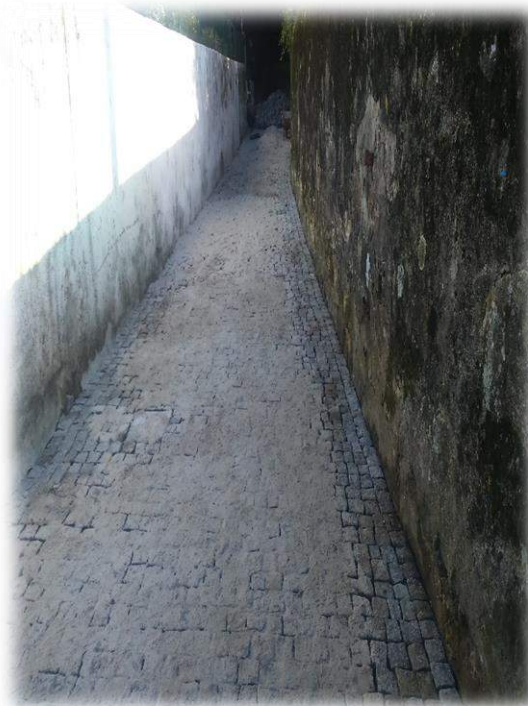
Figura n.º 15 – Trabalhos de pavimentação em cubo
