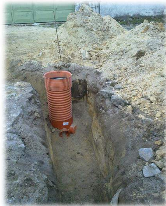
Figura n.º 13 – Instalação de caixa de ramal saneamento
