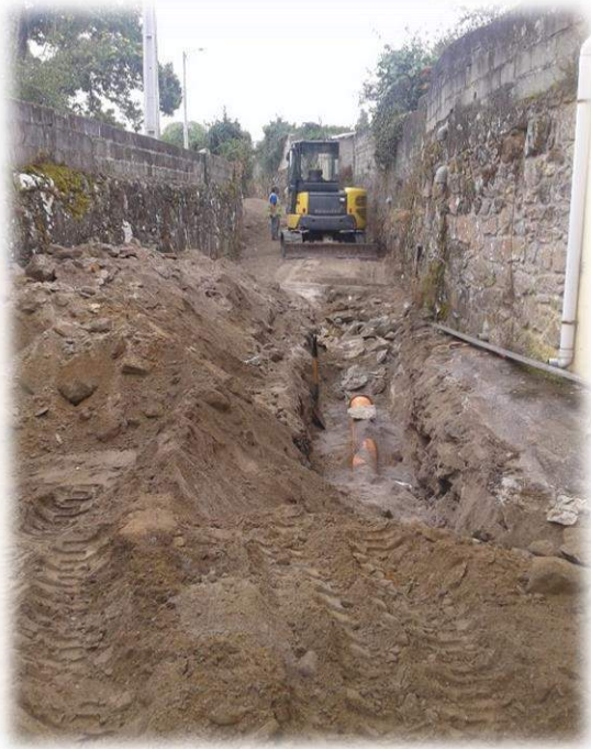
Figura n.º 3 – Instalação de coletor residual
