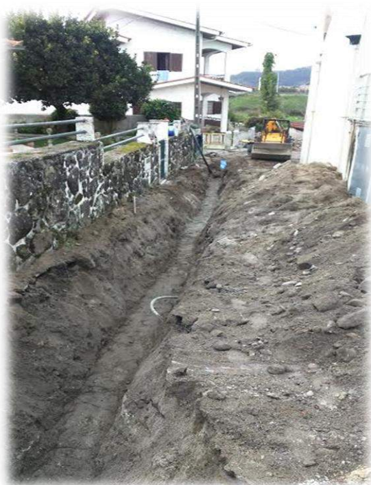
Figura n.º 14 – Instalação da rede de água
