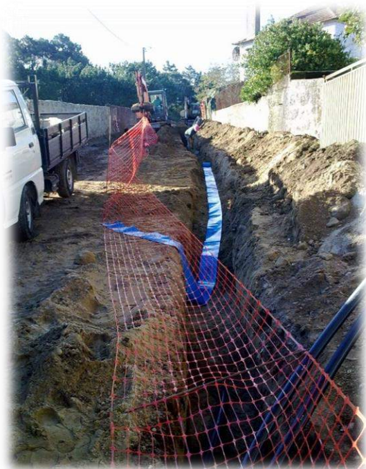
Figura n.º 12 – Instalação conduta de água
