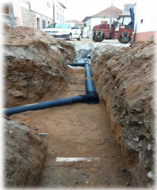
Figura n.º 10 – Instalação de coletor de saneamento Figura n.º 11 – Instalação de conduta de água
