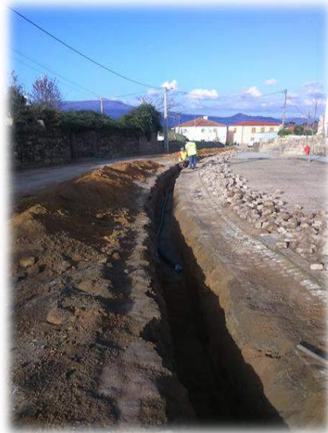
Figura n.º 10 – Instalação de coletor de saneamento Figura n.º 11 – Instalação de conduta de água
