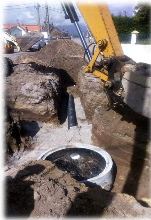
Figura n.º 6 – Box-Couvert de águas pluviais Figura n.º 7 – Instalação de coletor de saneamento
