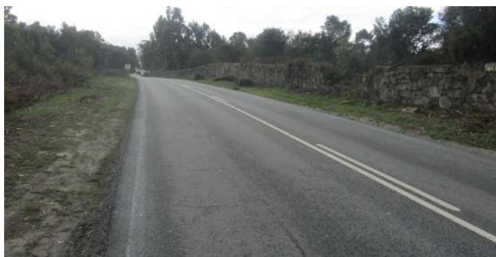
Fotografia III.2 - Perspetiva da EN 13-3 (norte/sul)
