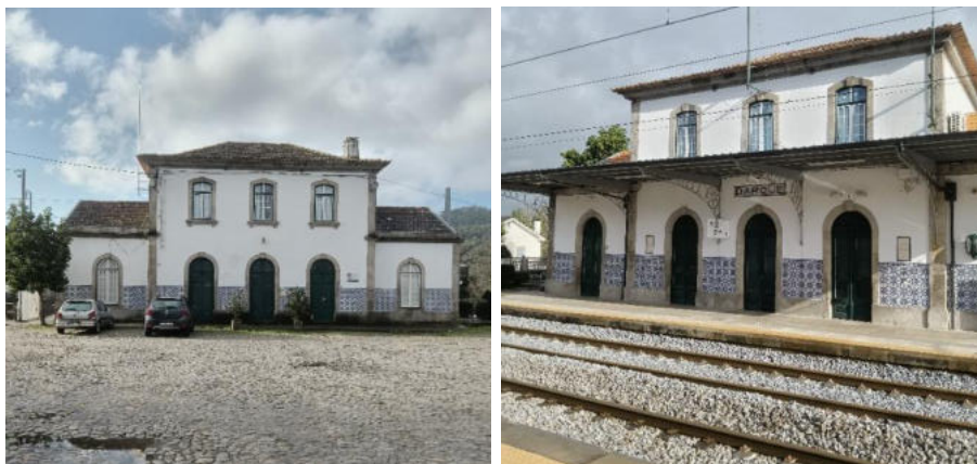
Figura 109. Estação Ferroviária de Darque
