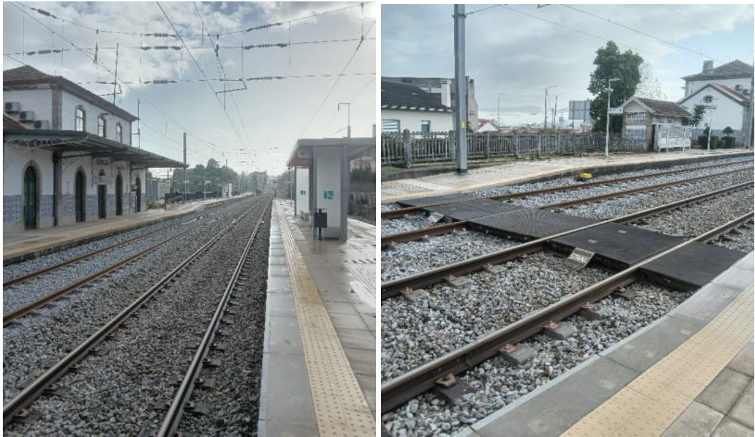
Figura 111. Características infraestruturais das plataformas de embarque da Estação Ferroviária de Darque e acesso pedonal entre ambas as plataformas
