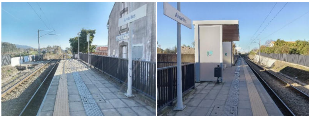
Figura 124. Apeadeiro Ferroviário de Alvarães
