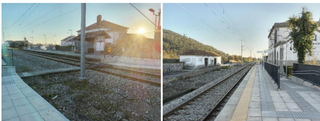
Figura 118. Apeadeiro Ferroviário de Carreço
