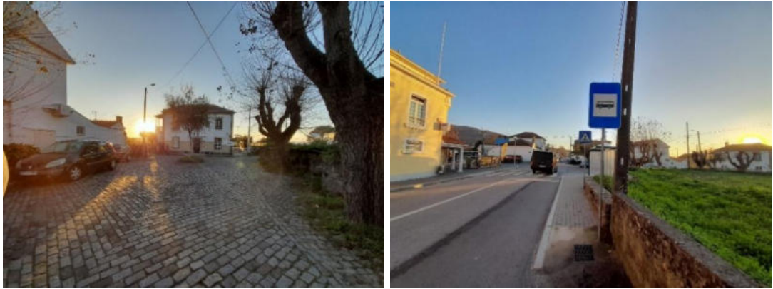
Figura 104. Características do acesso pedonal ao Apeadeiro Ferroviário de Afife e oferta de transporte coletivo rodoviário na sua envolvente
