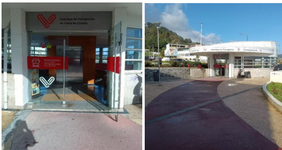
Figura 98. Terminal Rodoviário de Viana do Castelo
