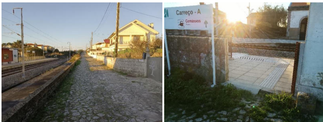
Figura 119. Características do acesso pedonal ao Apeadeiro Ferroviário de Carreço pela Rua da Estação
