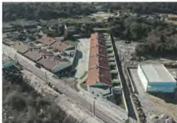
132 - Programa de Apoio ao Acesso à Habitação - Bairro de S. José - Alvarães - Lote 1
