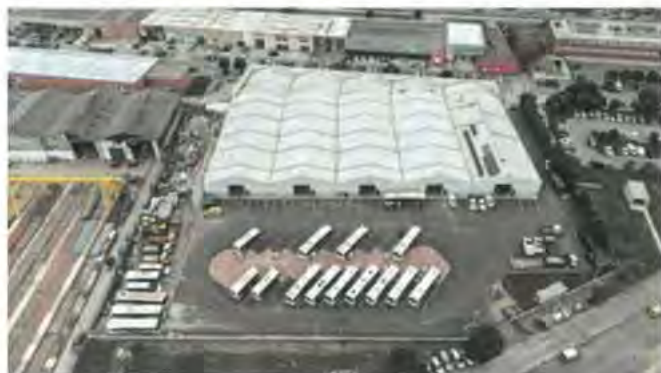
145 - Construção de Infraestrutura de Apoio ao Transporte Urbano
