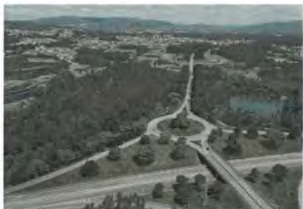
134 - Construção do Acesso Rodoviário da Z.I. do Vale do Neiva ao Nó da A28 (fotomontagem)
