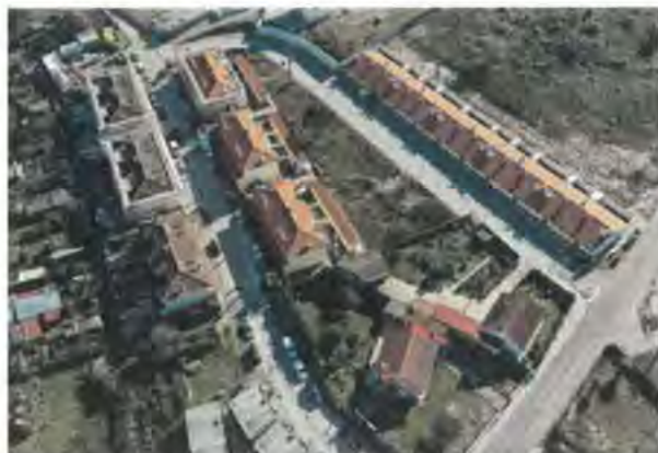
131 - Programa de Apoio ao Acesso à Habitação - Rua das Telheiras e Requalificação Urbanização Costeira - Alvarães
