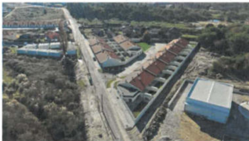
Urbanização Municipal de S. José, Alvarães
