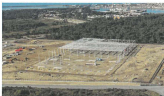
Construção da nova empresa Nordic EPOD, em Darque
